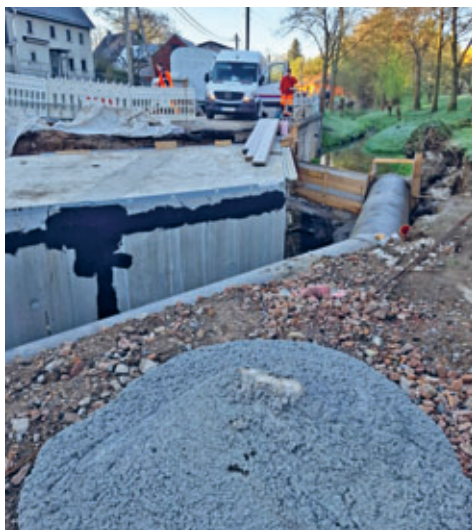
Brücke in Greifendorf
