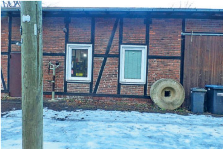
Foto 5 – Original des sog. „Restbahnhofs“, wo jetzt auf Rossauer Flur ein Handwerksmeister tätig ist.
