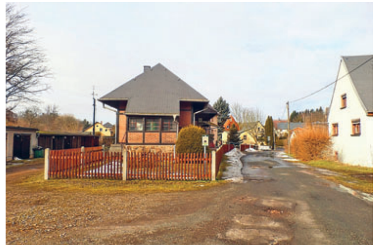
Fotos 7/8 – Schließlich Bilder in westliche Richtung, bereits in Ringethal. Auf einer Tafel das Foto aus den 1920er Jahren mit Gleisen, Bahn und Wagen, die gefüllt oder entleert wurden, wo auch die Ringethaler Mühle Schmaltz davon profitierte. Das letzte Foto zeigt die fast gleiche Stelle im Februar 2026.
