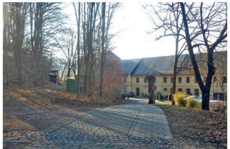
Foto 4 – Ausschnitt „Liebenhainer Mühle“, wo links die helle Ausbuchtung zu sehen ist. Dort fuhr die Bahn wieder auf den beschienten Weg zurück.
