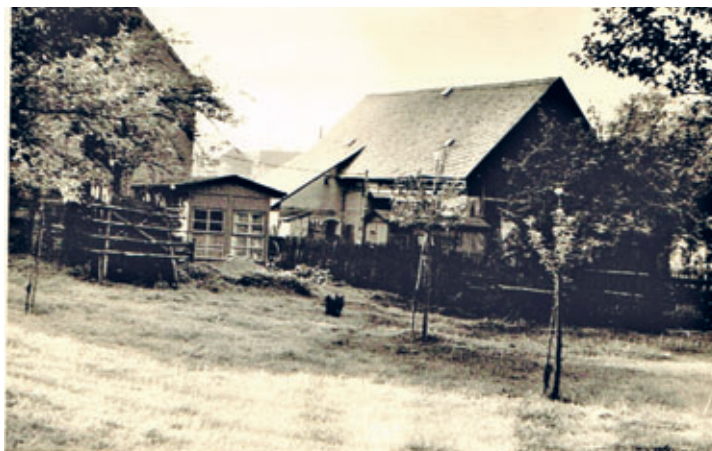
Kälberstall mit Bergeraum im Bau
