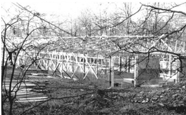
Nordseite, Aufnahme 1959 Stockmann/Röttig
