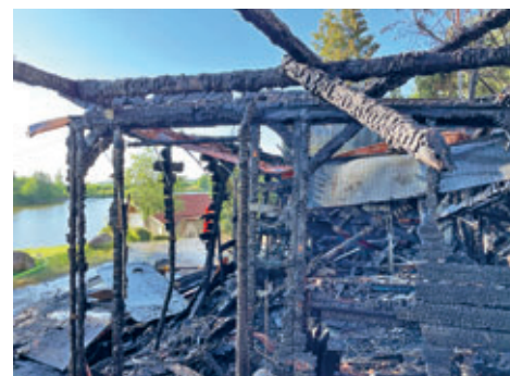
Mittels Wärmebildkamera wurden die Trümmer abschließend auf weitere Glutnester überprüft
