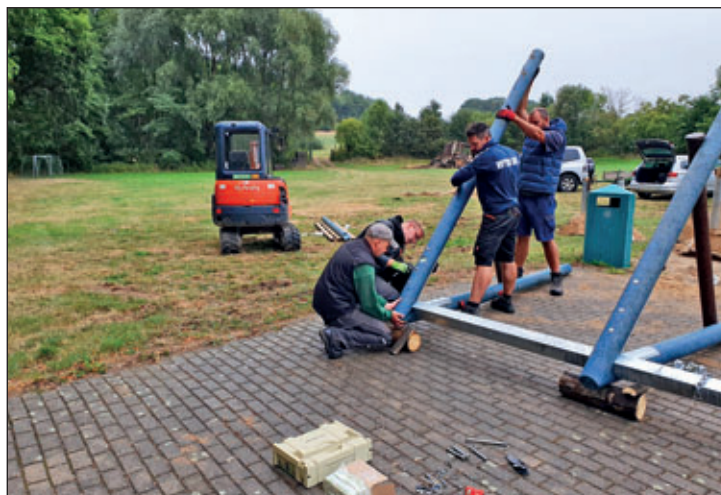
Aufbau der Schaukelanlage
