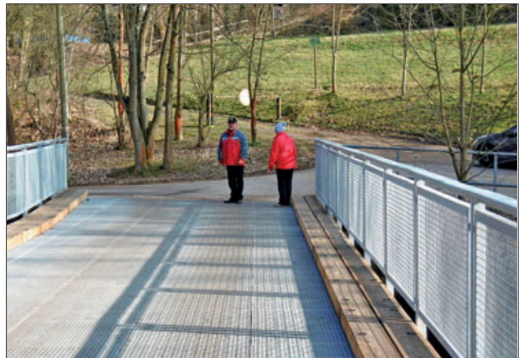
Erste Spaziergänger prüfen den Zustand der Brücke
